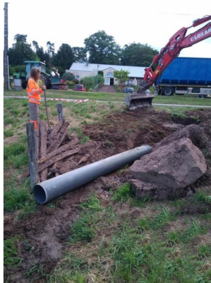
Réparation écoulement devant salle polyvalente
